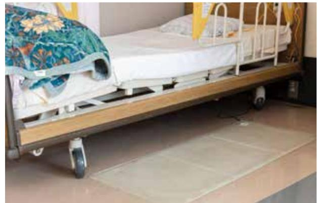
離床センサーは床置きマットに体重がかかったときにコールが鳴る「マットセンサータイプ」(写真)のほか、ベッドの柵にセンサーパッドを巻きつけるタイプのもの(商品名:タッチコール)も使用しています
